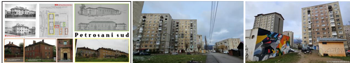
Fig 1-3 Cartiere muncitorești din diverse etape ale realismului socialist (Petroșani-Sud - Petroșani și Dallas - Uricani)/ Worker's Quarters from Different Stages of Socialist Realism (Petroșani-Sud - Petroșani and Dallas - Uricani)
